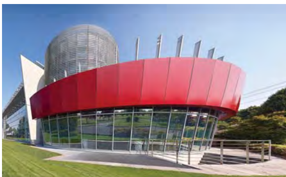
La sede di Pozzoli a Inzago (MI)
